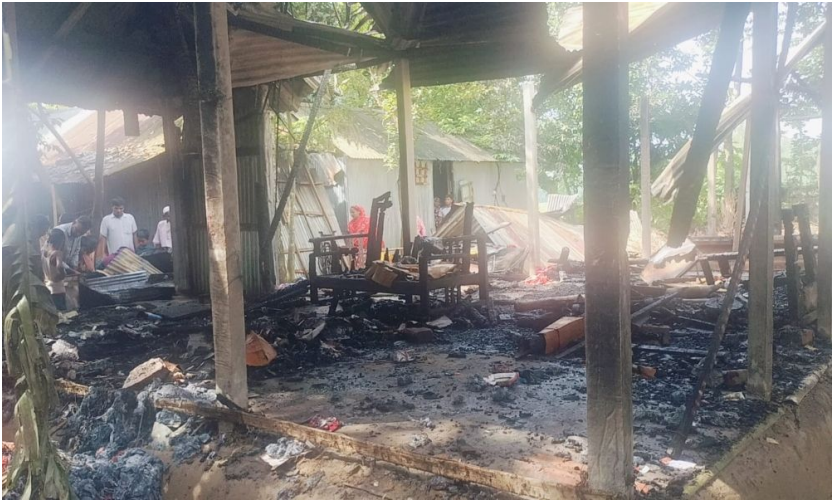
ভূত্বীতে আগুনে একই পরিবারের চার ঘর পুড়ে ছাই চাকুরগাঁওয়ের ভূত্বী উপজেলার বাসিয়া ইউনিয়নের কুমারপুর ফরেস্টের ডাংগাপাড়ায় অগ্নিকাণ্ডে একই পরিবারের চারটি ঘর পুড়ে গেছে। আজ সোমবার সকাল সাড়ে আট...
